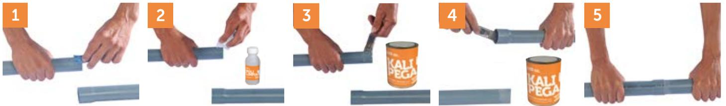
1 Lije la superficie a conectar, pruebe en seco la unión de tubos y/o accesorios.
